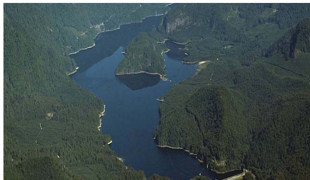
Coquitlam Lake Reservoir
